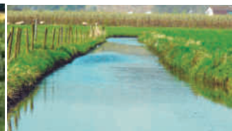
Desagües protegidos con vegetación
