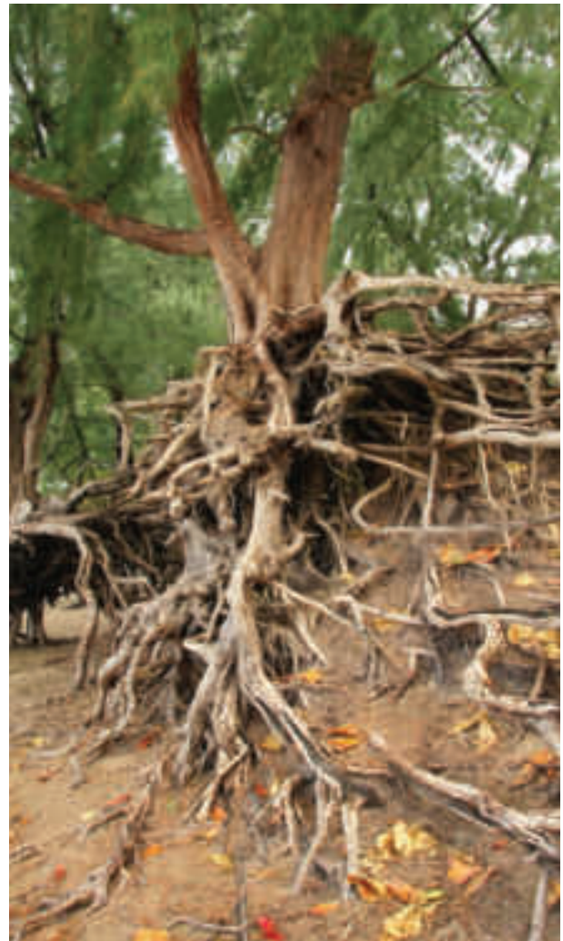
Suelo erosionado por acción del agua
