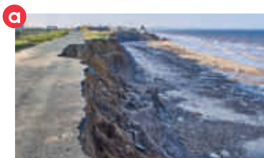
Deslizamiento de la carretera
