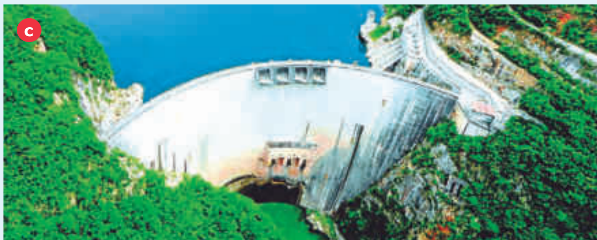
a. Parque solar en la comunidad la Llave, Nacaome, Honduras b. Aerogeneradores en San Marcos de Colón, Honduras c. Planta Hidroeléctrica Francisco Morazán "El Cajón", Cortés, Honduras.
