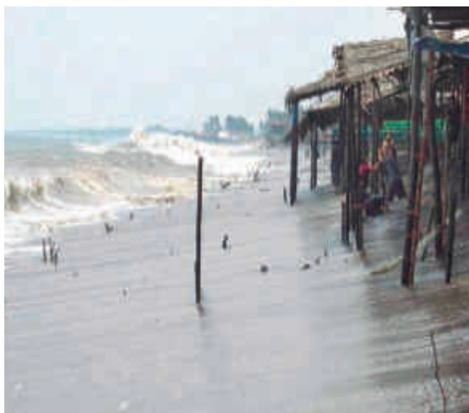
Foto tomada durante una marejada en la zona sur de Honduras.
