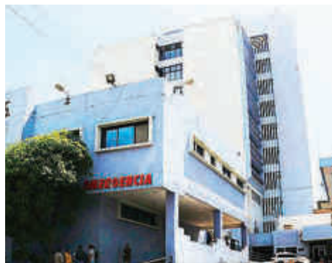
Entrada a emergencia del Instituto Hondureño de seguridad social (IHSS)
