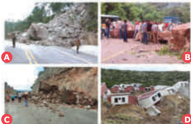
A. desprendimiento, B. desplome, C. vuelcos, y D. deslizamiento, Ciudad del Ángel, proyecto habitacional en Tegucigalpa, Honduras.
