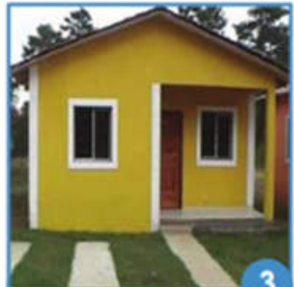
3 Vivienda ubicada en la ciudad de Tegucigalpa.
