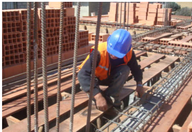
Personas trabajando en el rubro de la construcción.
