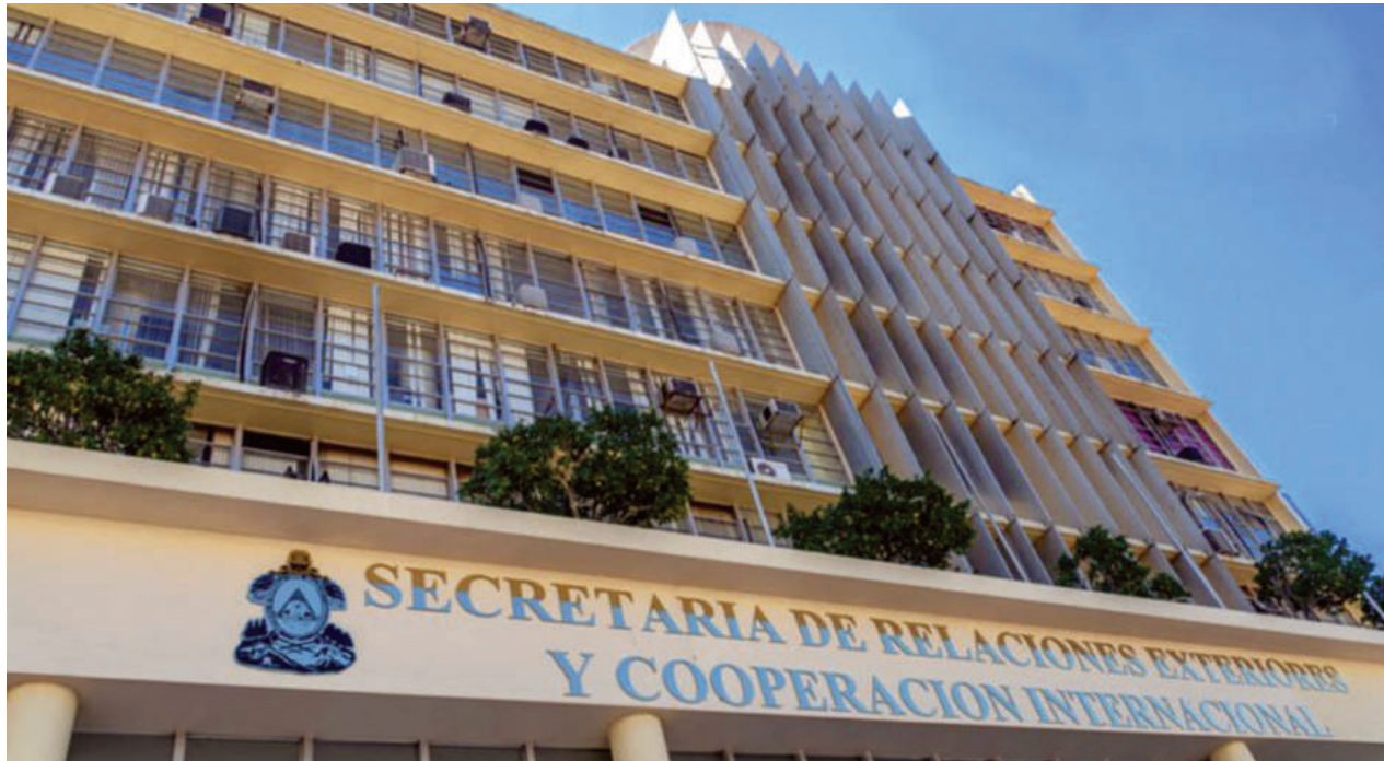
Edificio de la Secretaría de Relaciones Exteriores de Honduras o Cancillería, desde donde se dirige la política exterior del país.
