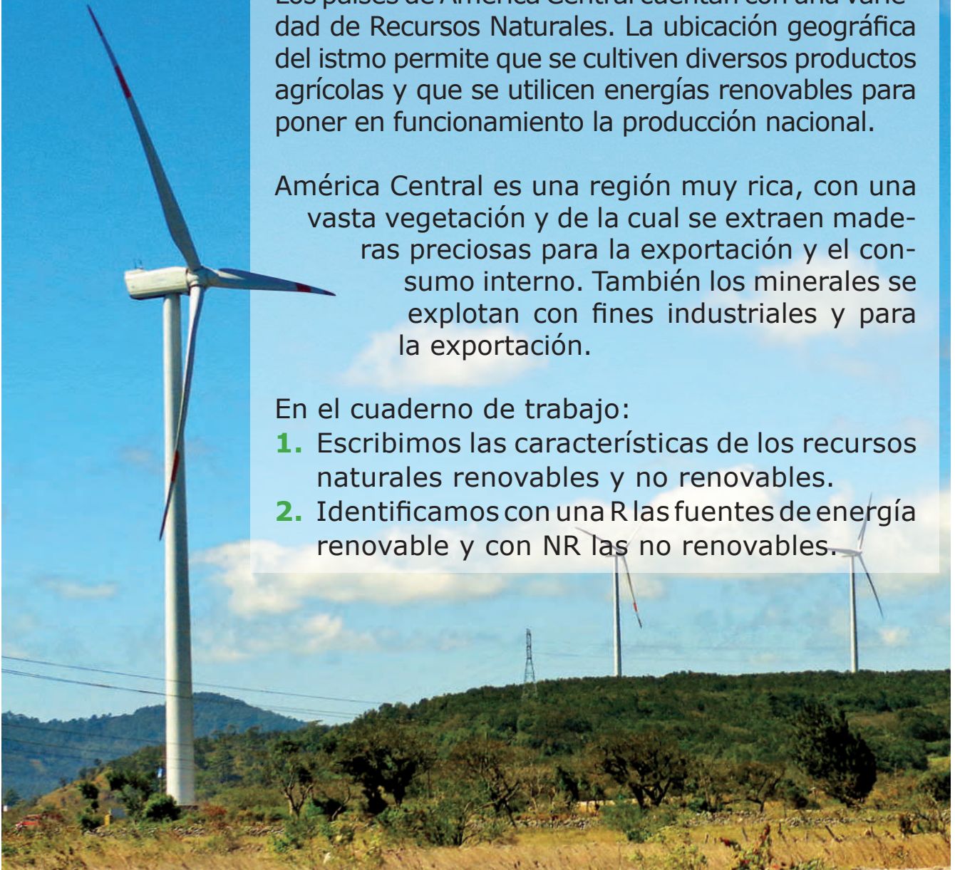
Planta de energía eólica (viento), se localiza sobre la meseta conocida como Plan de la Bodega o Cerro de Hula, en las cercanías de la ciudad de Tegucigalpa.
