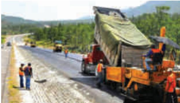
Construcción de carreteras: canal seco
